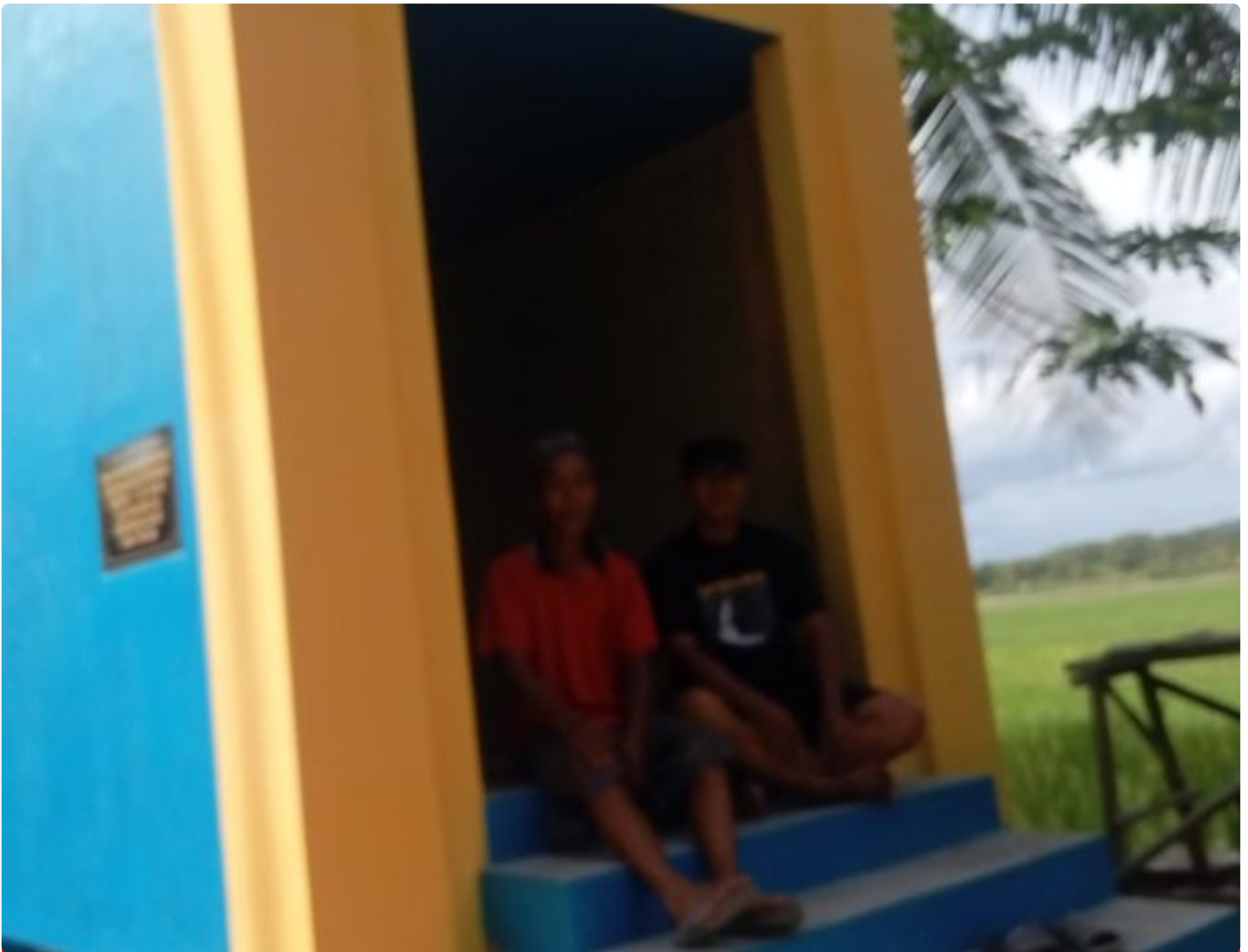
Pembangunan Irigasi Perpompaan di Desa Binangun
